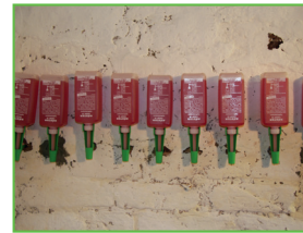
Selv installasjon av horisontal tetning
