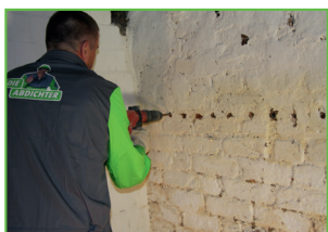
Horisontal boring i den horisontale fuge
